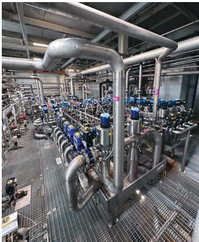
Pose et raccordement d'une grille de vannes chez Lesaffre. La difficulté était de couper une grille de vannes existante pour y insérer une nouvelle grille de vannes entre les éléments qui ont été dissociés. L'ensemble des soudures ont été réalisées sur place avec contrôle endoscopique à 100%.
