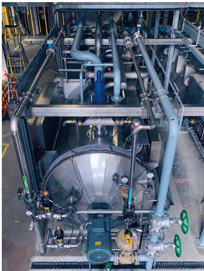
Raccordement d'un autoclave chez mars petcare.
