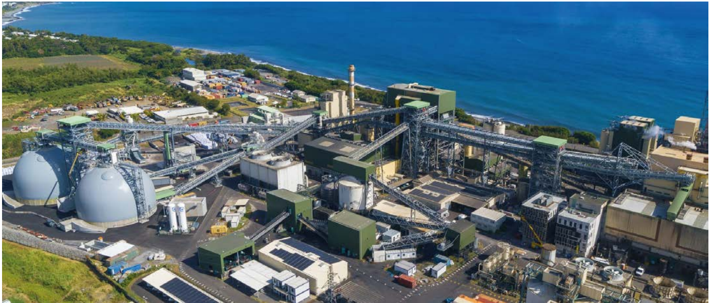
La Centrale de Bois Rouge, un projet d'envergure qui reflète l'implication du Groupe dans le domaine de la transition énergétique.
