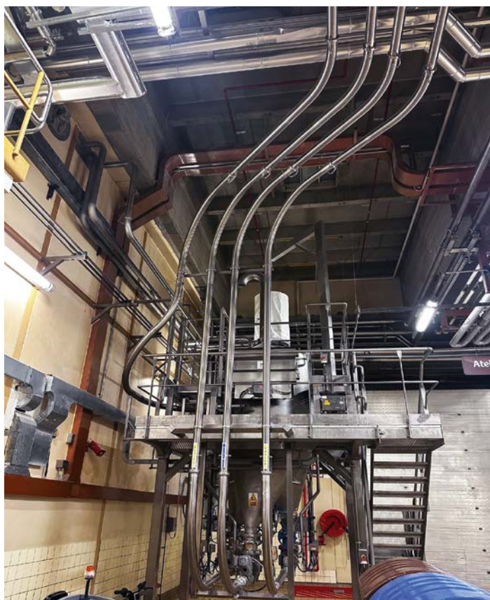
Confection d'une tuyauterie de transfert pneumatique de sucre en poudre. Tuyauterie réalisée avec des coudes de rayon 1200mm.
