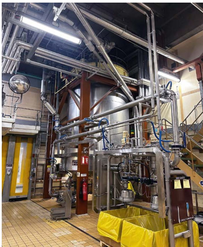
Pose et raccordement d'un skid pour filtrer le chocolat suite aux nouvelles normes internes au groupe MARS dans le monde.
